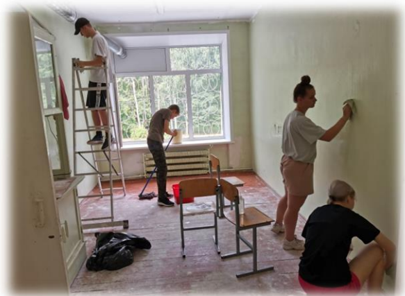
Рис. 27. Уборка помещения после покраски потолка
