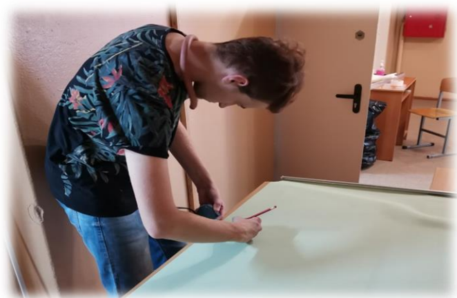
Рис. 30. Подготовка рулонной шторы к монтажу
